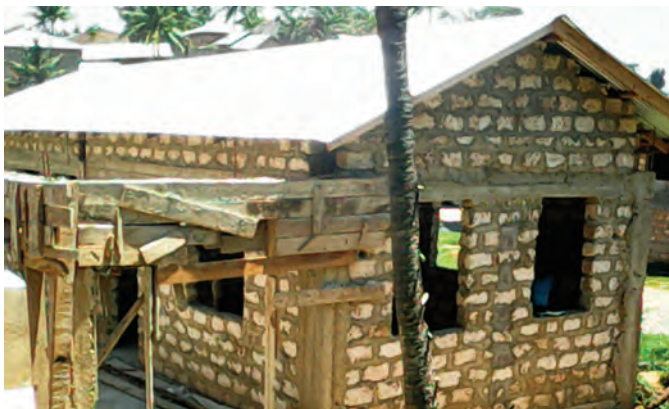
Der Rohbau für die ersten Klassenräume der Grundschule ist abgeschlossen.
