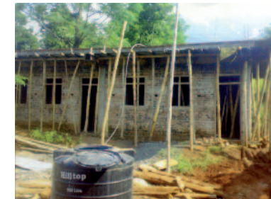
Rohbau des neuen Gebäudes für den naturwissenschaftlichen Unterricht
