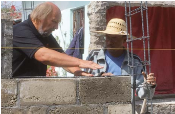
Unterstützung beim Wiederaufbau mit deutscher Handwerkserfahrung
