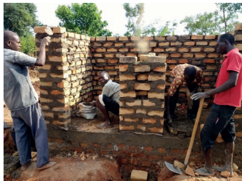
Arbeit an den Grundmauern für die Latrinen
