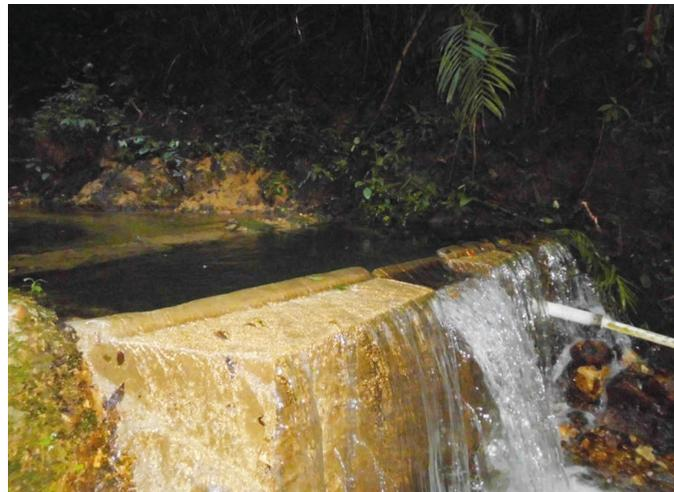
Eines von vier Stau- und Sedimentationsbecken des Trinkwasserversorgungssystems
